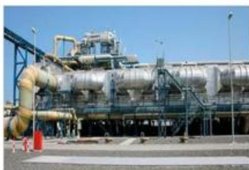
多级闪蒸海水淡化
