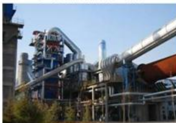
水泥厂低温余热闪蒸发电
